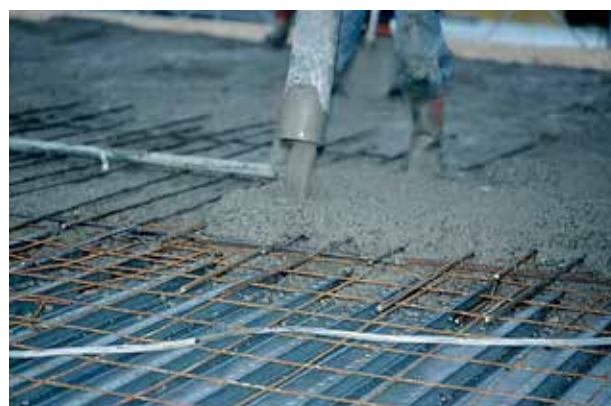
Betongen ska utbredas jämt så att plåten inte får lokala nedböjningar
