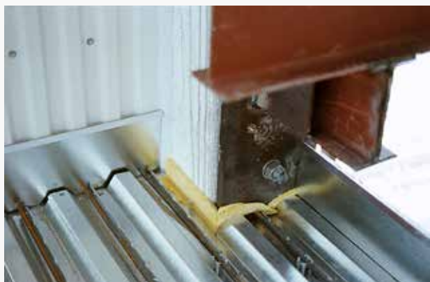
Det är enkelt att på plats utföra goda detaljanslutningar.
