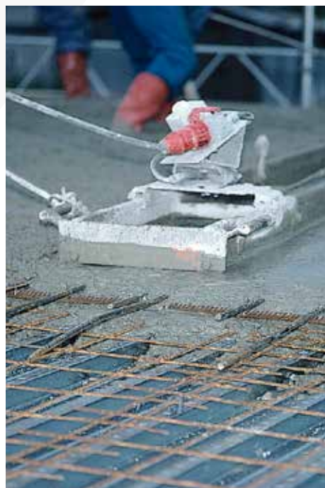
Betongpåjutning görs till färdig yta i ett moment.
