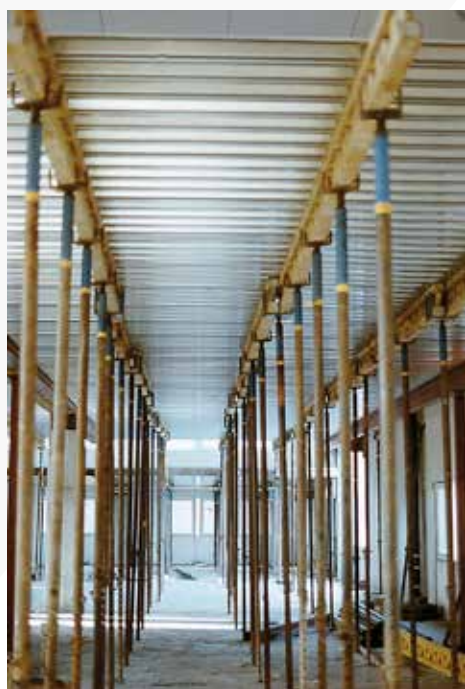
Ett glesst lager bockryggar stöttar plåten under gjutfasen.
